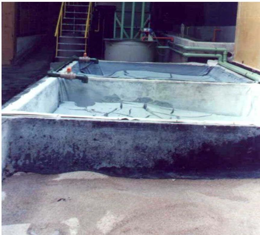
FIGURA 7 - LEITO DE SECAGEM PARA ADENSAMENTO DE LODO
